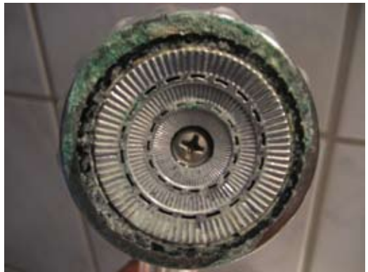
Ein kontaminierter Duschkopf
