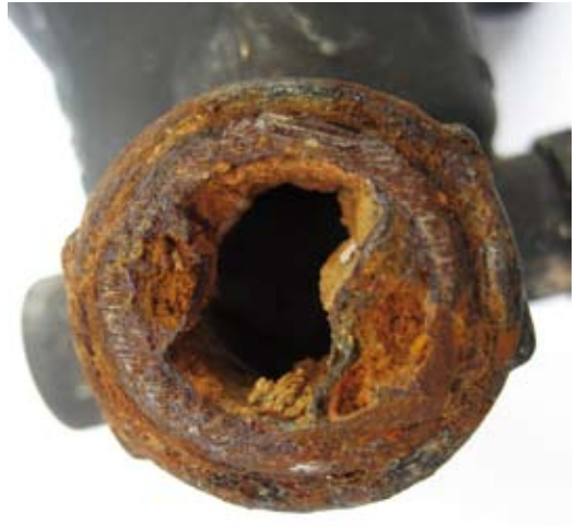
Eine sechs Jahre alte Wasserleitung in einem Mehrfamilienhaus
