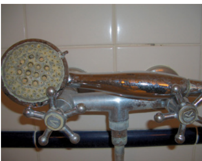
Abbildung 1 Verunreinigter Duschkopf im privaten Haushalt.
